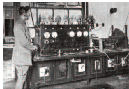
Équipement technique du poste de la Tour Eiffel en 1922.
